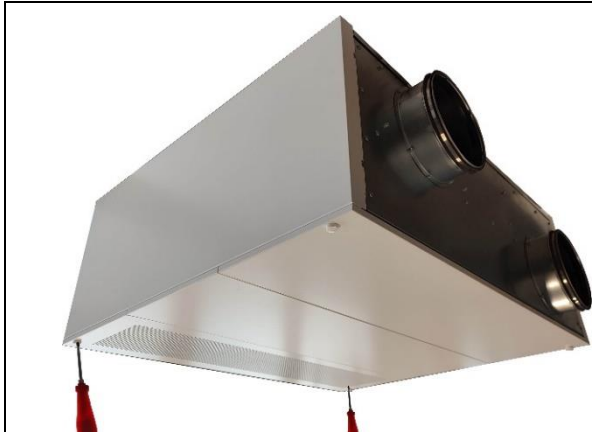
1) Svitare le due viti del pannello inferiore grigliato
