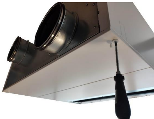
3) Svitare le due viti del pannello inferiore verso espulsione/estrazione aria
