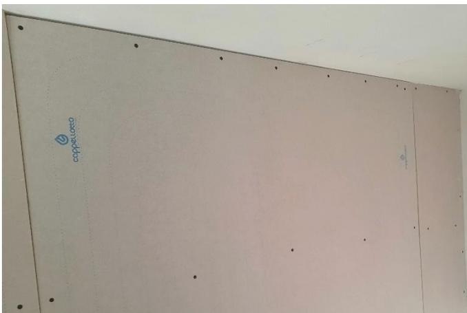
Figura 4 Esempio di installazione pannelli radianti soffitto
