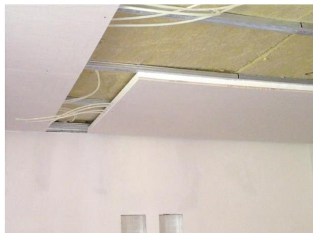
Gli spazi fra i pannelli (per il passaggio delle dorsali) e gli spazi vuoti devono essere coperti con i cosiddetti pannelli passivi, cioè privi di tubazioni all'interno. Si consiglia di avere uno spazio fra le lastre e il soffitto di almeno 10 cm per poter ispezionare l'impianto. Ultimata la posa dei pannelli attivi e dopo aver svolto la prova dell'impianto si può procedere alla tamponatura mediante pannelli di tamponamento passivi.
